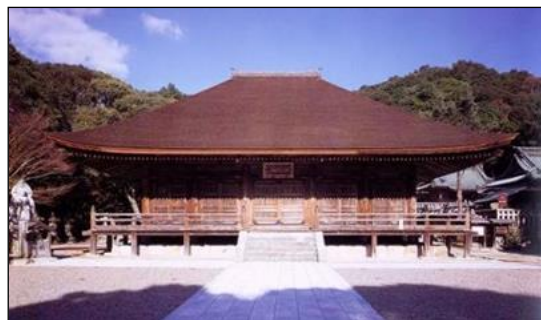
図2-3-13 滝山寺本堂(重要文化財)
